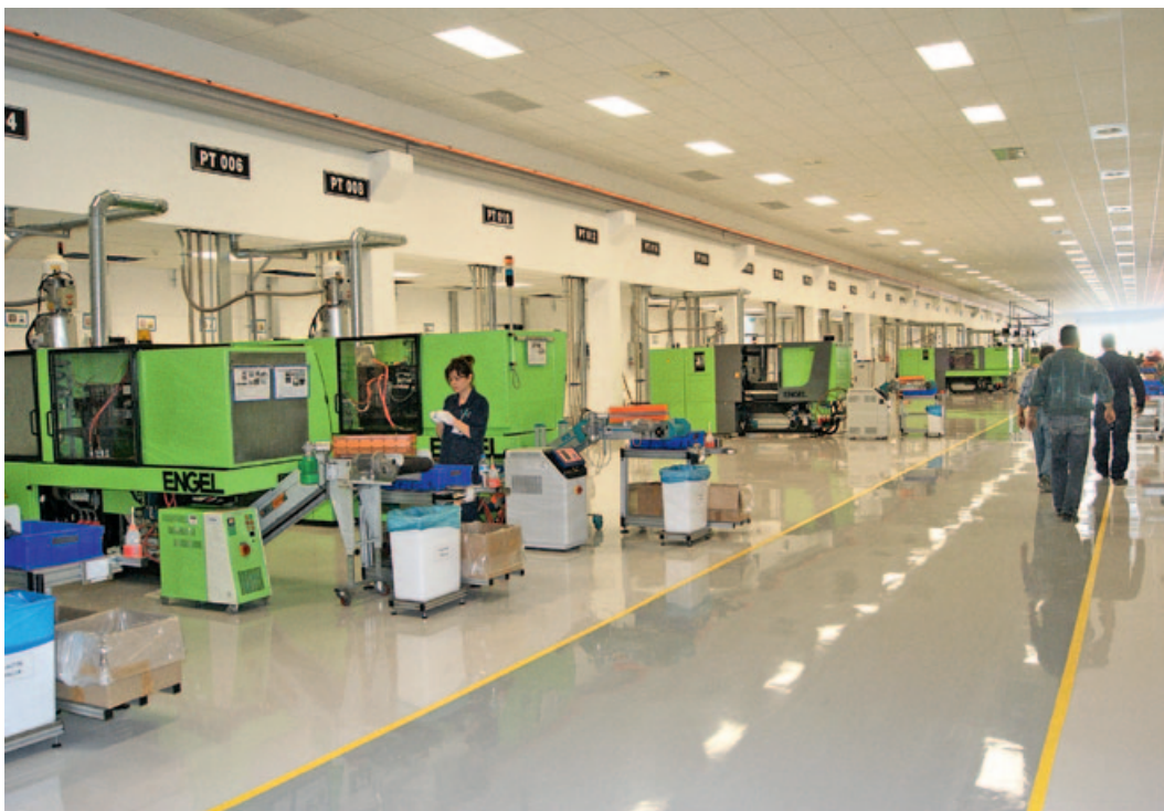
65 Spritzgießmaschinen haben Anfang April in dem komplett neuen Gebäudekomplex in Izmir den Betrieb aufgenommen
